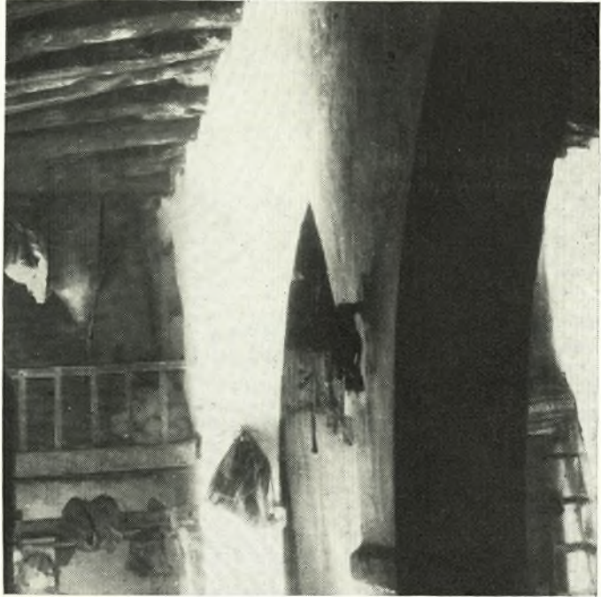
Είχ. 1.—Σπίτι Έμμ. Μα- ρινάκη. Έσωτερικό.
