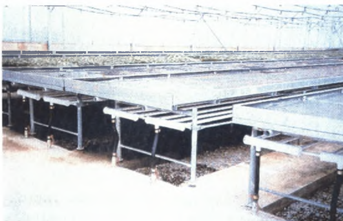
Σχήμα 1.8. Σωλήνες θέρμανσης κάτω από τα τραπέζια ανάπτυξης γλαστρικών φυτών.
