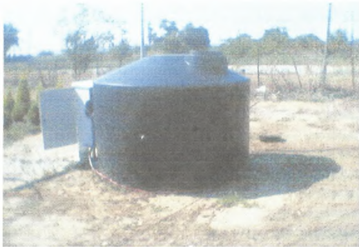
Εικόνα 23. Δεξαμενή αποθήκευσης επεξεργασμένων αποβλήτων
