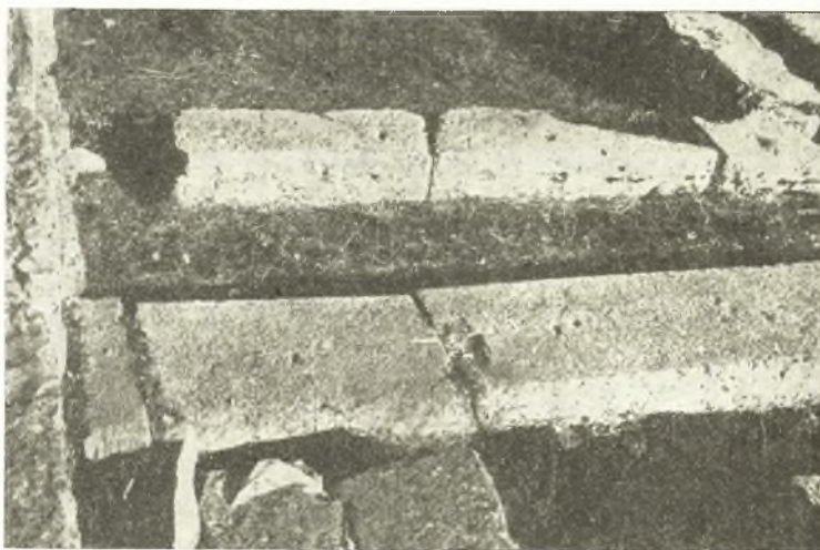
Εἰκ. 47. Θεμέλιον τῆς ΒΑ. στοᾶς εἰς τὸ σημεῖον συνδέσεως (ββ) μετὰ τοῦ ἐξωτερικοῦ τοίχου.
