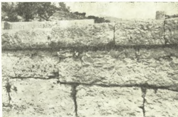
Εἰκ. 48. Τμήμα ἀνατολικοῦ τοίχου, ὀρωμένον ἐκ τοῦ ἐσωτερικοῦ, εἰς τὸ σημεῖον συνδέσεως τοῦ τοιχοβάτου μὲ τὴν νοτιάν στοάν.
