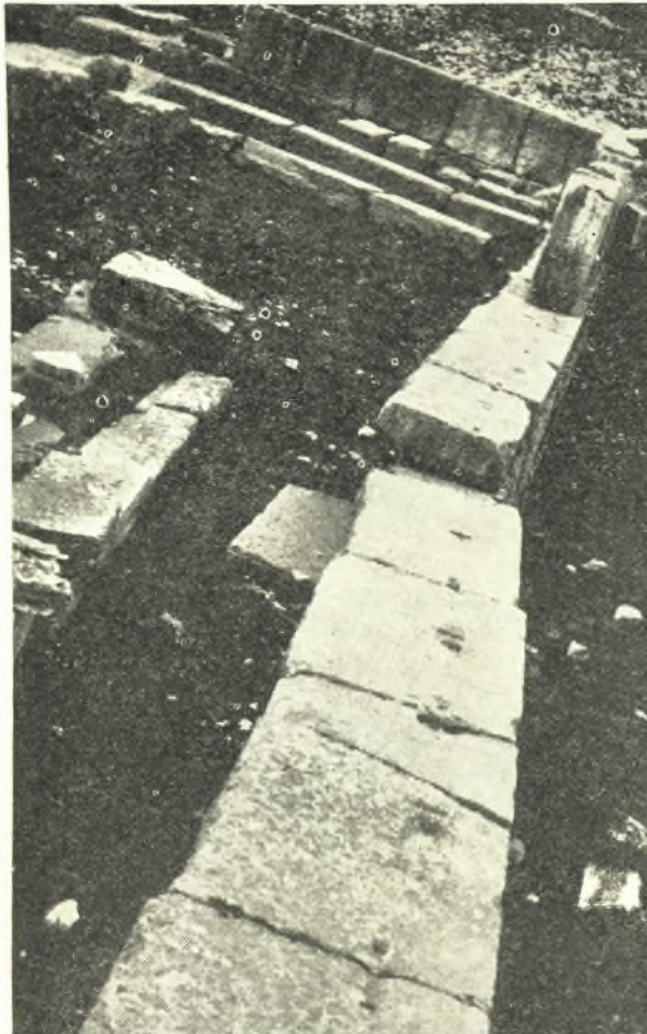
Εἰκ. 62. Ἡ Ἄν. πλευρὰ τοῦ ἐξωτερικοῦ τοίχου. Περὶ τὸ μέσον εἶναι ὀρατὴ ἡ καθίζησις τοῦ τοίχου ἕνεκα τῆς ὑπ' αὐτὸν μεγάλης ὀπῆς.
