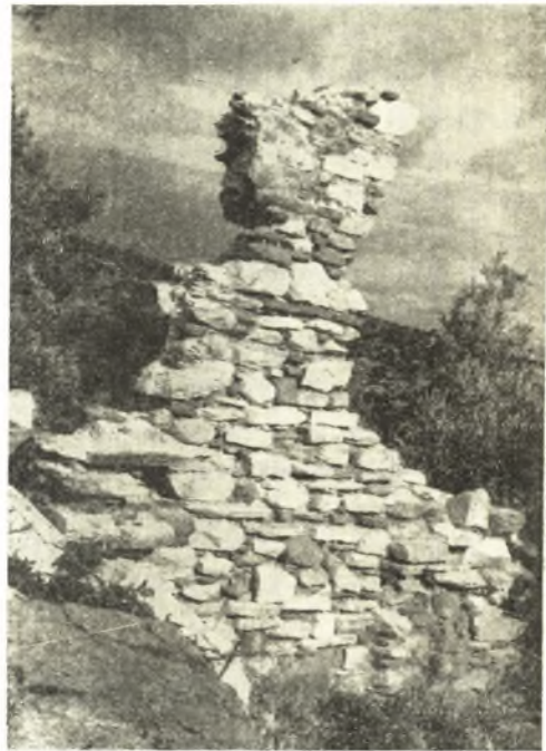
Εἰκ. 12. Ὁ βόρειος τοίχος (ἐκ τῶν ἔσω) τοῦ ναῖσκου Ἁγίας Ἄννης Μαραθῶνος.
