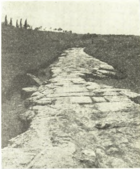
Εἰκ. 3. Τὸ ἄνευ αὐλακώσεων τμήμα τοῦ διόλκου, ἐπὶ τοῦ ὁποίου ἐξετείνοντο τὰ πρόσθετα ἐπὶ τοῦ πλακοστρώτου θεμέλια.
