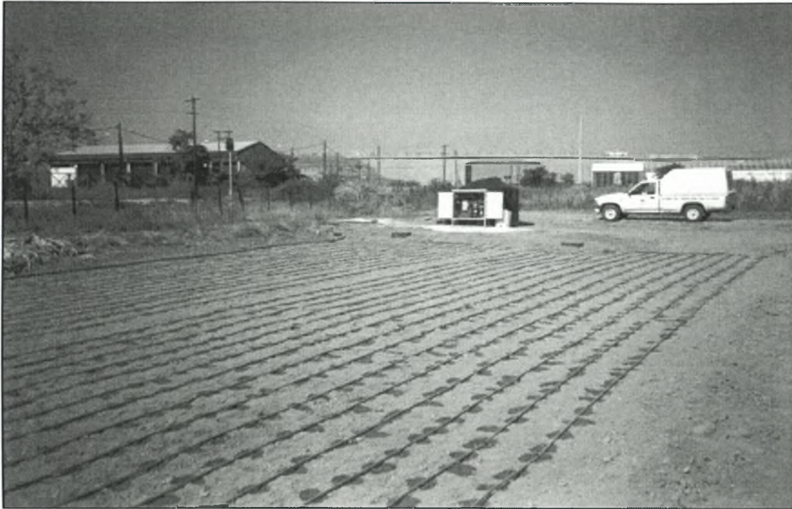
Εικόνα 12. Έλεγχος λειτουργίας του αρδευτικού συστήματος.
