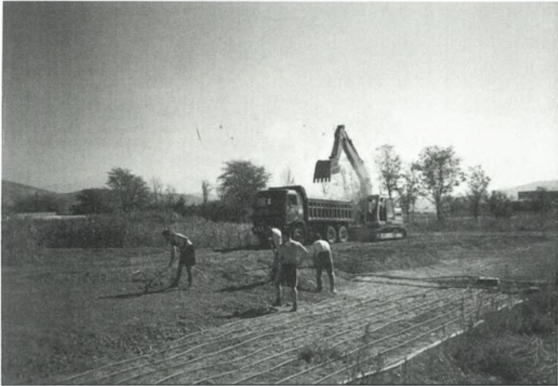
Εικόνα 14. Επιχωμάτωση και ισοπέδωση του αγρού.
