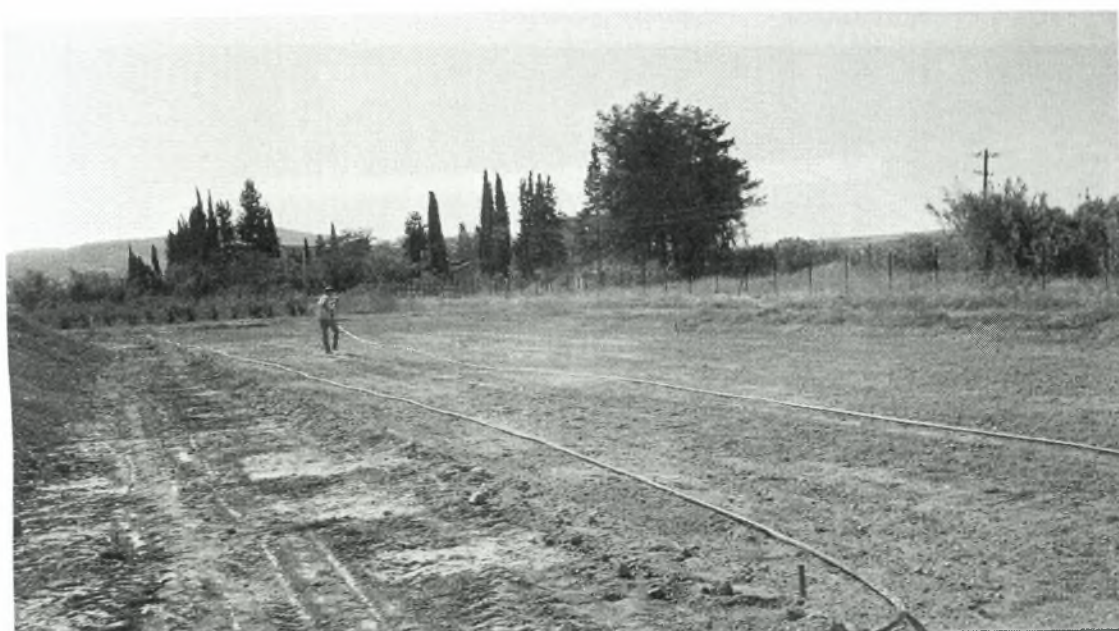
Εικόνα 11. Εγκατάσταση του αρδευτικού συστήματος.
