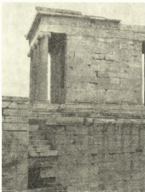
Εἰκ. 24. Βόρειος πλευρὰ τοῦ πύργου. Κλίμαξ.
