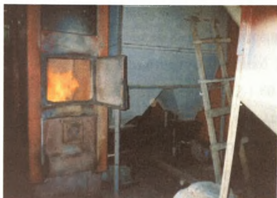
Εικ 39 : καύση Μίσχανθου (καυστήρας)
