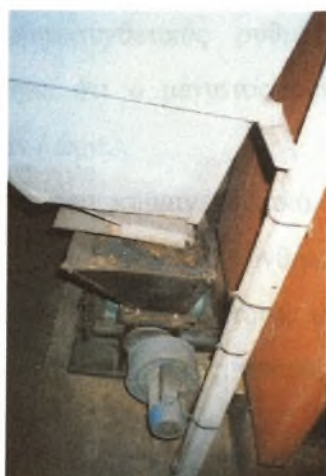
Εικ 40 : σύστημα τροφοδοσίας υλικού για καύση
