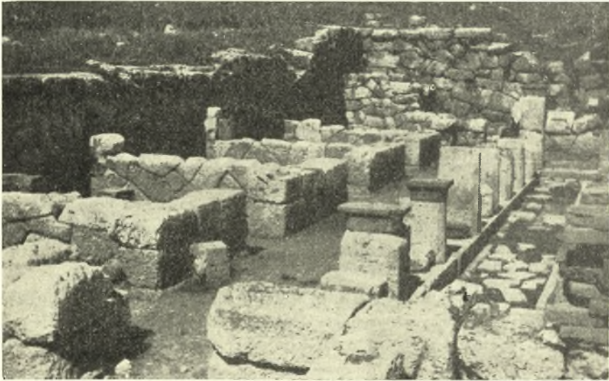
Εἰκ. 1. Ἡ δυτικὴ πλευρὰ τοῦ οἰκοδομήματος, ὀρωμένη ἐκ νότου.
