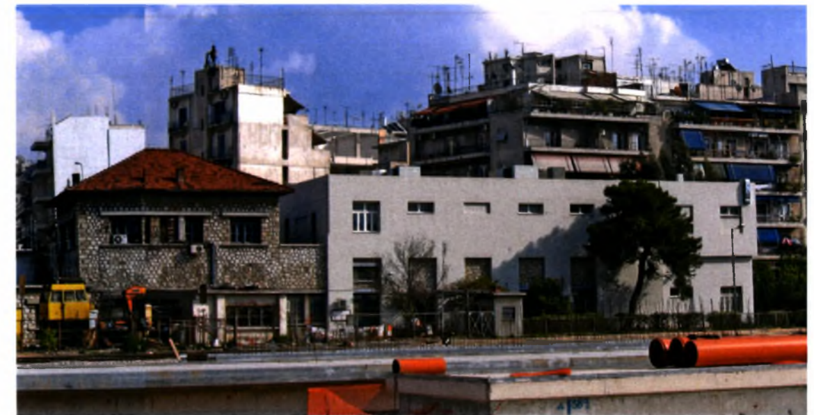
Boηθητικό κτίριο ΟΣΕ
