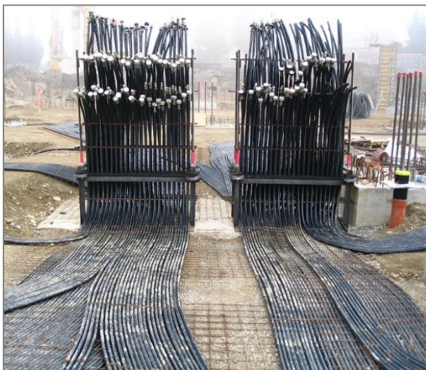
Σχήμα 2.12 Σύνδεση κυκλωμάτων με τους συλλέκτες – διανομείς. [9]
