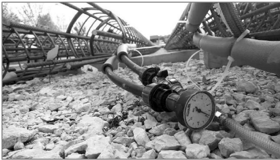
Σχήμα 2.8 Τοποθέτηση μανόμετρου στις απολήξεις. [24]
