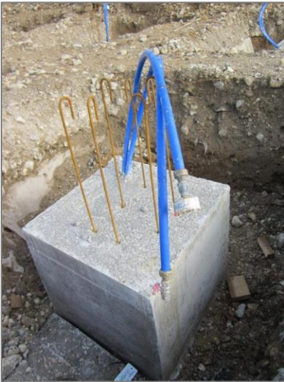
Σχήμα 2.10 Απολήξεις σωλήνων στον κεφαλόδεσμο. [34]
