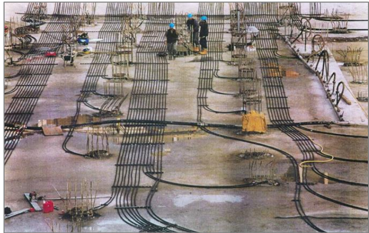
Σχήμα 2.11 Συλλεκτήριο οριζόντιο δίκτυο σωλήνων των ενεργειακών πασσάλων. [36]
