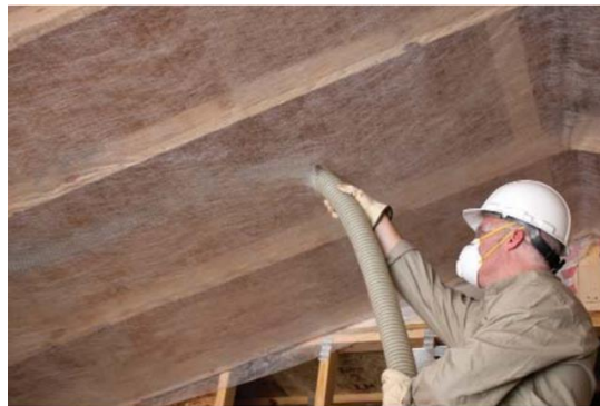
Σχήμα 3-19 Τοποθέτηση κυτταρίνης μέσω ακροφυσίου σε στέγη ( US GreenFiber, LLC )
