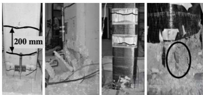
Σχήμα 2-11 Αστοχία υποστυλωμάτων (Realfonzo et al., 2009)
