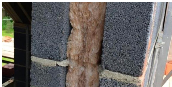
Σχήμα 3-2 Εφαρμογή θερμομόνωσης στην εξωτερική τοιχοποιία (Bournas, 2018).
