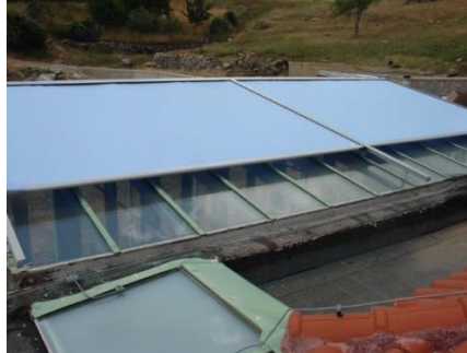
Σχήμα 3-6 Περσίδες μερικής σκίασης ( http://www.kamxis.gr )
