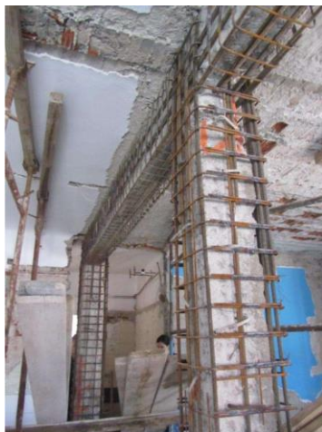
Σχήμα 2-8 Μορφή μανδύα οπλισμένου σκυροδέματος ( www.alfakat.gr )
