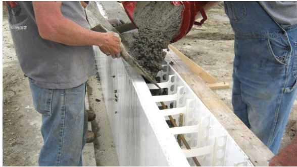
Σχήμα 4-4 Χύτευση σκυροδέματος στο εσωτερικό ICF πάνελ
