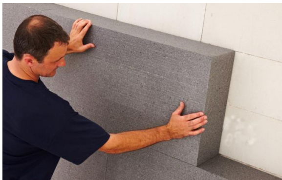
Σχήμα 3-17 Τοποθέτηση στρώματος διογκωμένης πολυστερίνης ( Knauf, 2017-03 )
