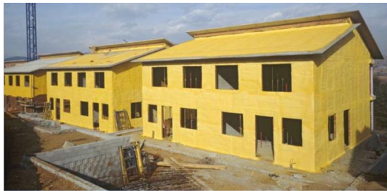
Σχήμα 3-20 Θερμοπρόσοψη με εξωτερικά τοποθετημένο αφρό πολυουρεθάνης ( Elastogran GmbH )
