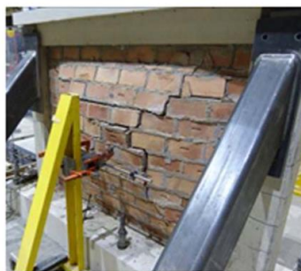
Σχήμα 2-40 Κατανομή ρωγμών στο επίπεδο της πλήρωσης (Koutas et al., 2018)
