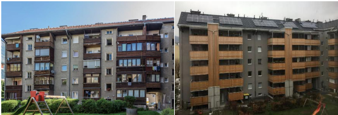
Εικόνα 35. Συγκρότημα κατοικιών στη Sebastian- Scheel Strabe 18-18b, Ίνσμπρουκ. Πριν και μετά την ανακαίνιση
