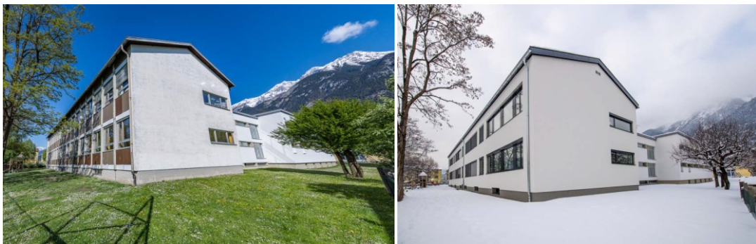
Εικόνα 36. Δημοτικό σχολείο στην Angergasse 18. Πριν και μετά την ανακαίνιση
