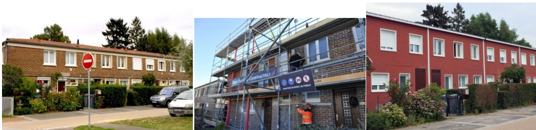
Εικόνα 19. Hem France E=0. Πριν, κατά τη διάρκεια και μετά την ανακαίνιση
