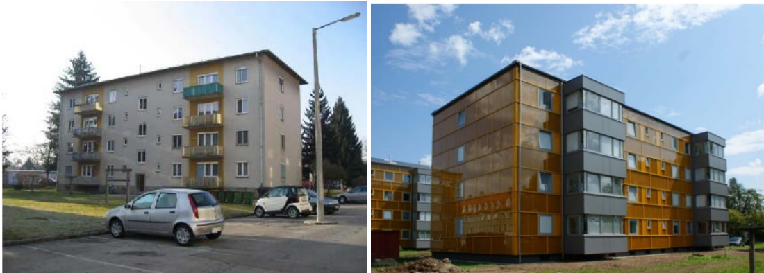
Εικόνα 20. Ανακαίνιση συγκροτήματος κατοικιών στην περιοχή Dieselweg στο Γκρατς της Αυστρίας. Πριν και μετά την ανακαίνιση Πηγή: (Miloni et al., 2011)
