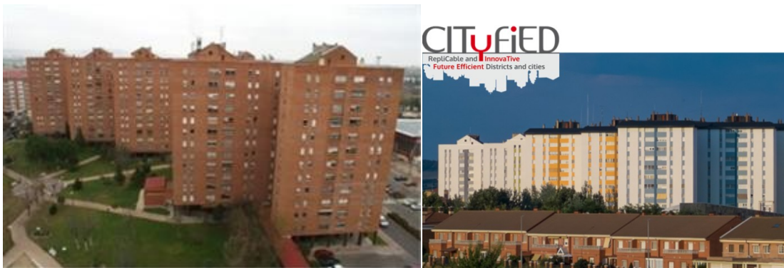
Εικόνα 22. Άποψη των κτιρίων μετά την ανακαίνιση ( αριστερά Φάση I & δεξιά Φάση II)
