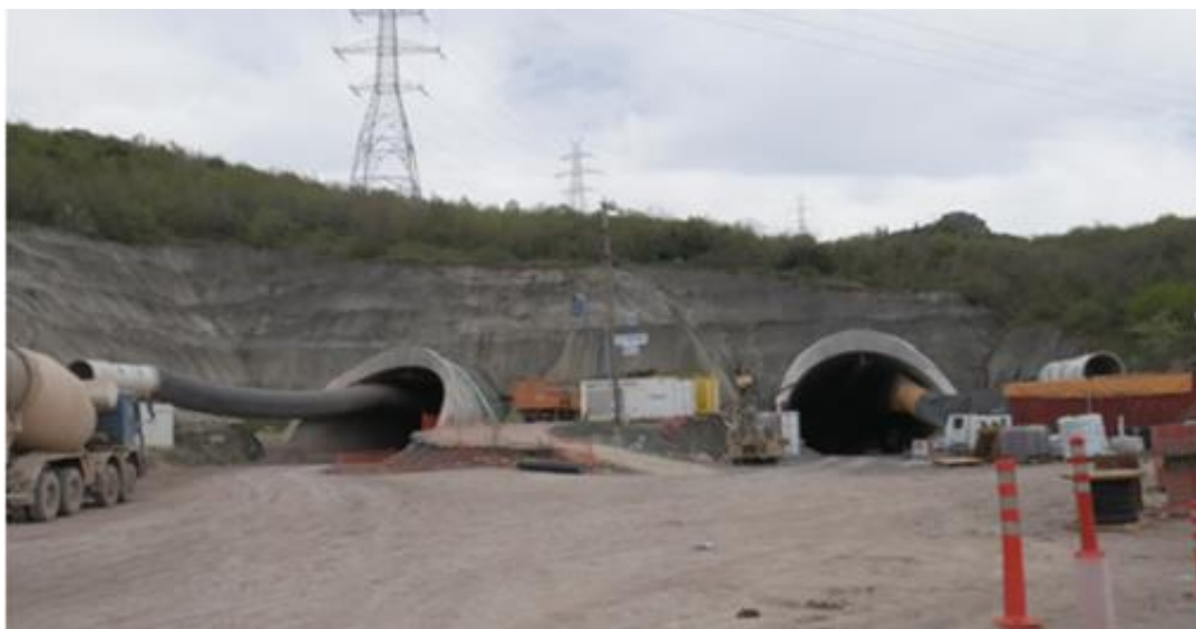
Εικόνα 30: Η υπό κατασκευή σήραγγα Όθρυς (Πηγή: https://www.thessaliaeconomy.gr/blog/eidiseis/notios-e65-dyskolies-sti-siragga-tis-othryos )
