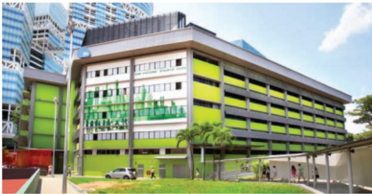
Εικόνα 7: LaunchPad @ one-north, πηγή: clc.gov.sg
