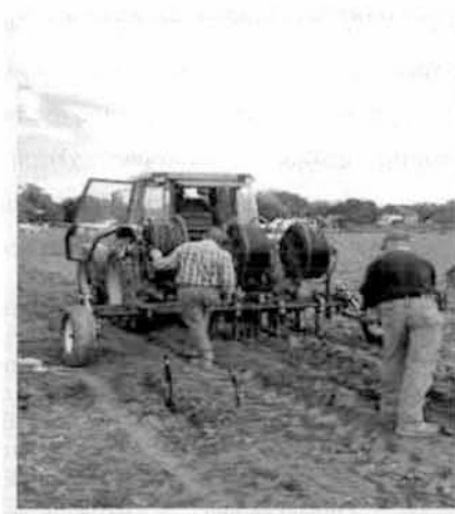
Εικόνα 3.4: Τοποθέτηση υπόγειου συστήματος άρδευσης με υπεδαφοθέτη
