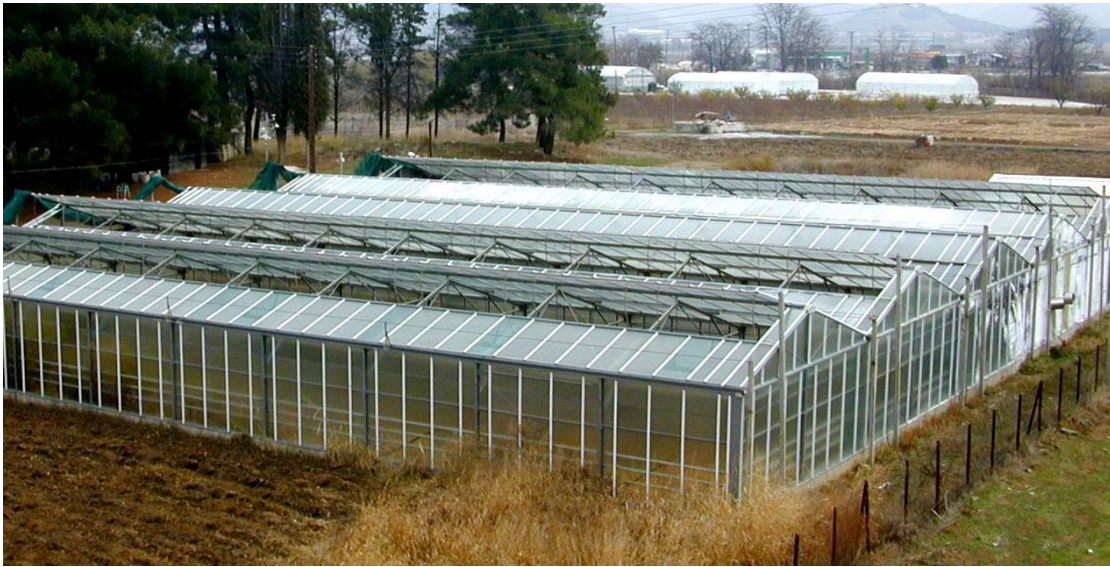
Εικόνα 3.2. Εξωτερική άποψη των παραθύρων οροφής του θερμοκηπίου.
