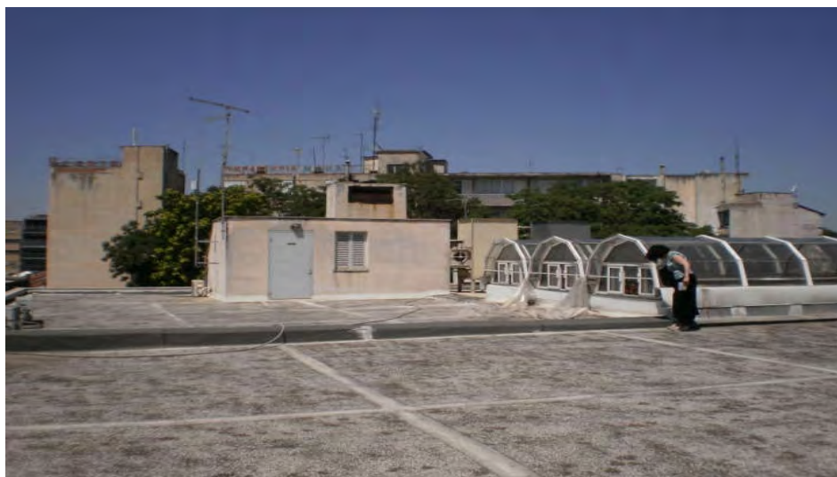
Εικόνα 7.2.2 1: Τμήμα του αίθριου, ο αρμός διαστολής και ένα από τα δύο κλιμακοστάσια. Το δάπεδο είναι από μωσαϊκό
