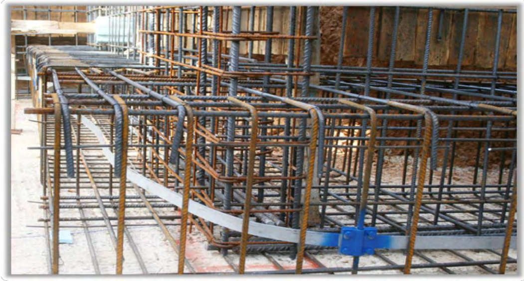
Εικόνα 26 Τοποθέτηση θεμελιακής γείωσης
