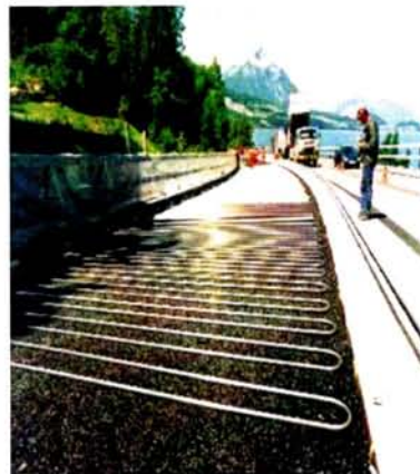
Σχήμα 3.8: Σωλήνες εκπομπής - απορρόφησης θερμότητας σε οδόστρωμα (Olgun, 2013)
