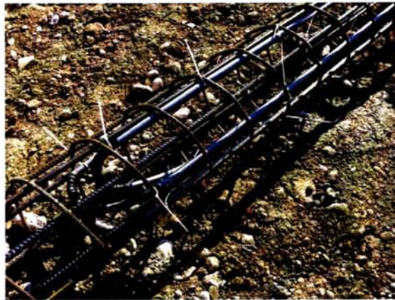
Σχήμα 4.7: Φωτογραφία κλωβού οπλισμού ενεργειακού πασσάλου με ενσωματωμένους βρόχους σωλήνων (Zarrella et al., 2013)
