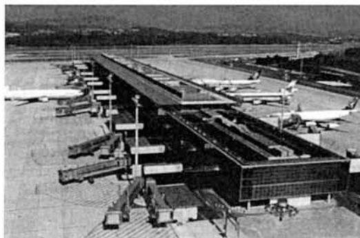
Σχήμα 3.13: Φωτογραφία του Dock Midfield terminal, Zurich airport, Switzerland (Laloui et al., 2006)
