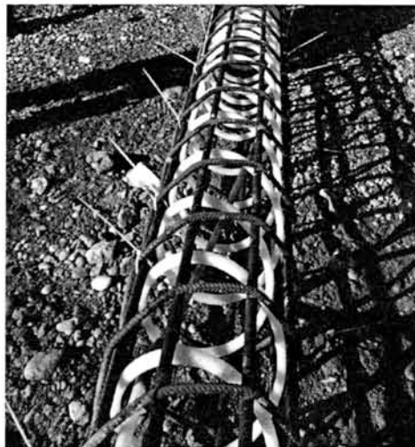
Σχήμα 4.9: Φωτογραφία κλωβού οπλισμού ενεργειακού πασσάλου με ενσωματωμένους σωλήνες σε σχήμα σπείρας (Zarella et al., 2013)
