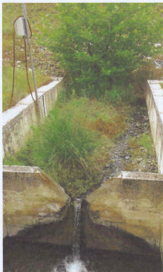
Σχήμα 2.18 Εκόνα από τη διάταξη μέτρηση διαρροών στον πόδα του φράγματος στην τωρινή της κατάσταση.
