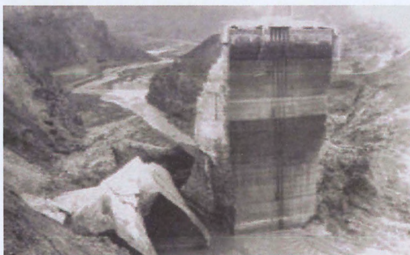
Σχήμα 1.6 Φράγμα Saint Francis, εικόνα μετά την αστοχία του φράγματος (Πηγή: http://www.expericela.com/Calendar/eventmore.asp?key=16595 )
