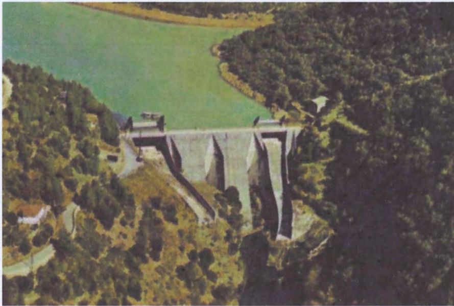
Σχήμα 1.3 Αντιρηδωτό φράγμα Λάδωνα-Πελοπόννησος (Πηγή: http://users.itia.ntua.gr/nikos/energy/Fragm.pdf .)
