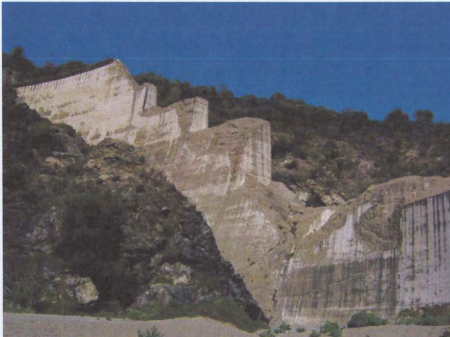
Σχήμα 1.7 Φράγμα Malpasset (Πηγή: http://www.webpages.uidaho.edu/~simkat/geol345_files/malpasset front.jpg )
