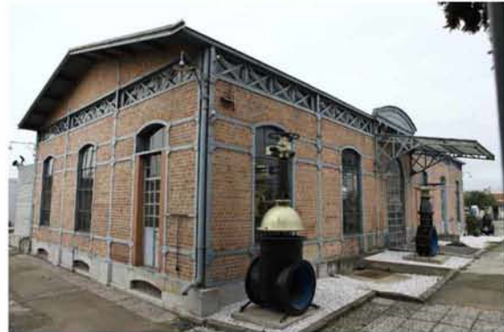
Εικόνα 7: Μουσείο Ύδρευσης Θεσσαλονίκης (πρώην αντλιοστάσιο Ο.Υ.Θ.)
