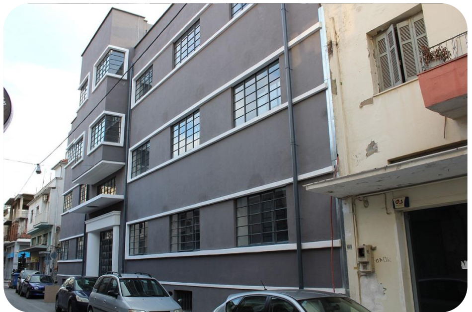
Εικόνα 2 Μέρος του κτιρίου Ματσάγγου μετά την ανακαίνιση για Πανεπιστημιακή χρήση
