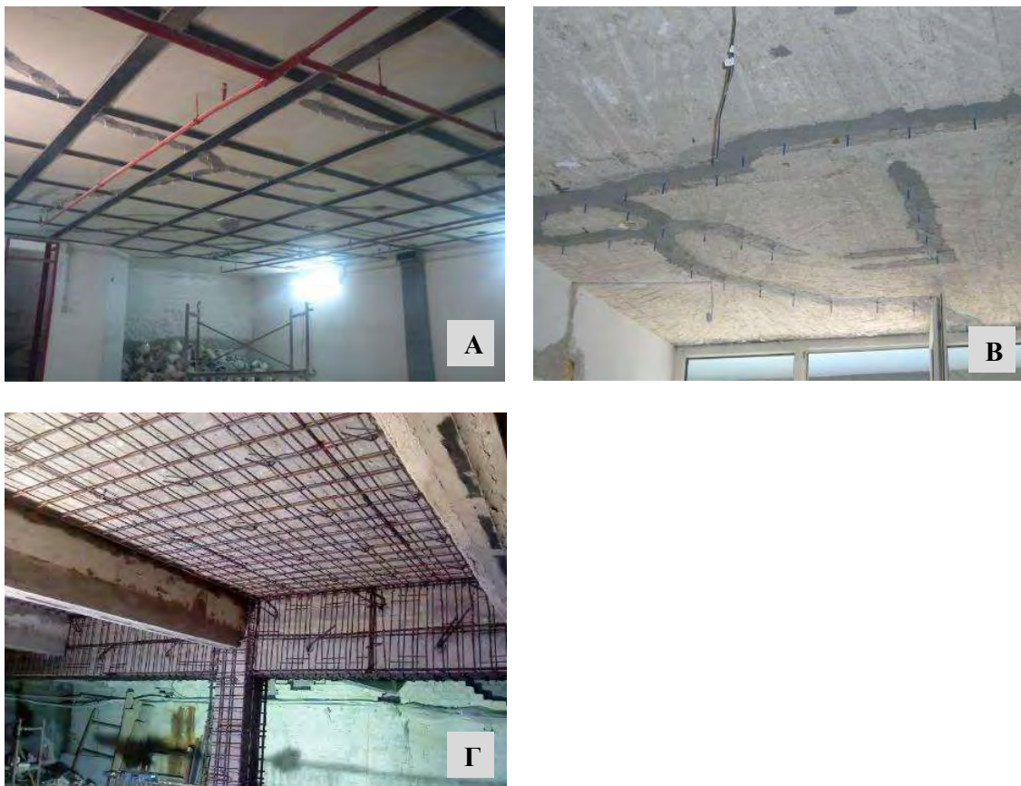
Σχήμα 1.12 : Α. Ενίσχυση πλάκας με χρήση ταινιών FRP αντί καμπτόμενου οπλισμού, Β. Ενίσχυση πλάκας με χρήση ρητινενέσεων για πλήρωση ρωγμών, Γ. Ενίσχυση πλάκας με τοποθέτηση μανδύα οπλισμού [14]
