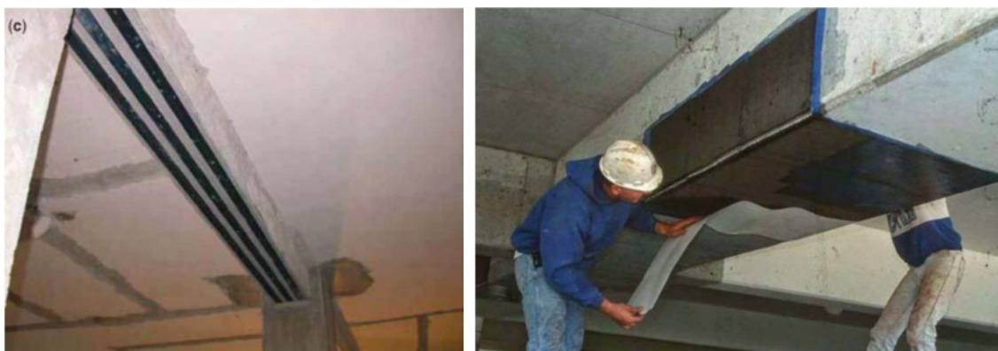
Σχήμα 1.7 : Ενίσχυση δοκού με χρήση CFRP. Αριστερά ενίσχυση σε κάμψη, δεξιά ενίσχυση σε τέμνουσα [9]
