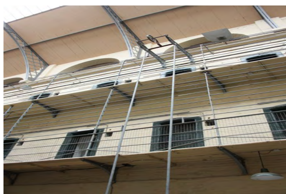
Εικόνα: 8.3.9.2 Σύστημα τροφοδοσίας
