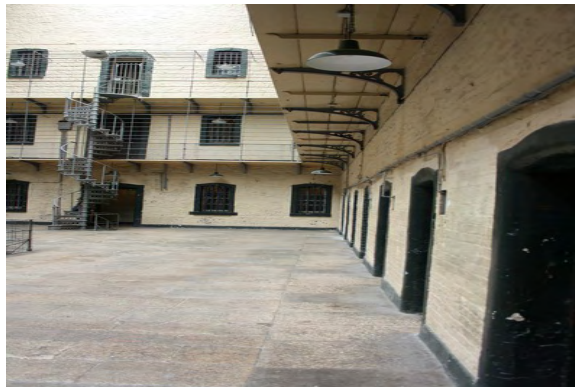
Εικόνα 8.3.5: Όψη από τον εσωτερικό περίβολο
