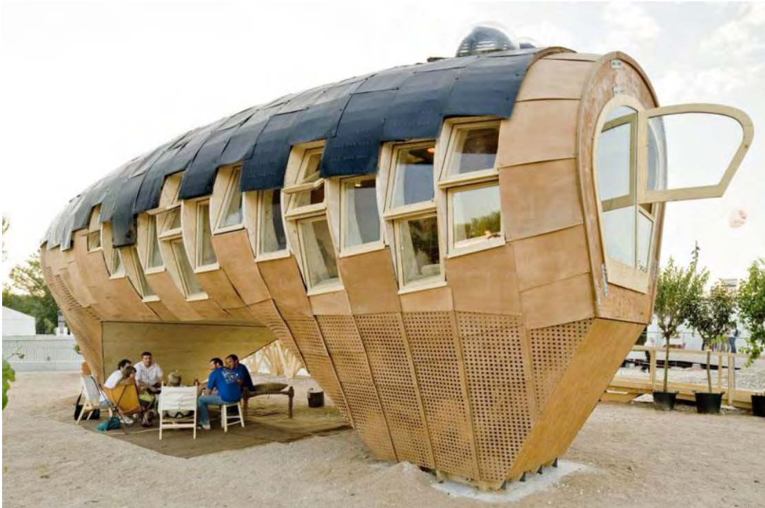
Εικόνα 10: Πρωτότυπη κατασκευή Fab Lab House
