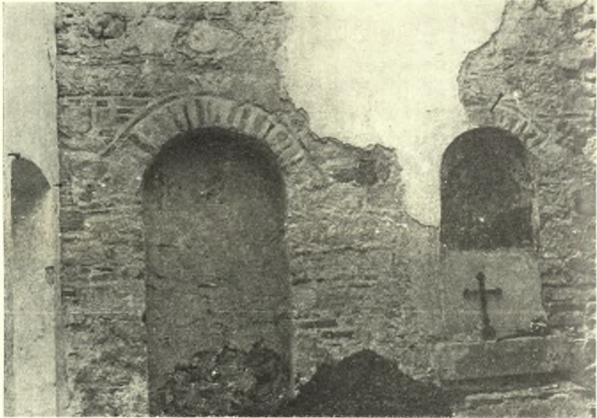
Εἰκ. 6. Βυζαντιναὶ τυφλαὶ ἀψίδες ἐπὶ τῆς ἐντοιχίσεως τοῦ μεγάλου τόξου τῆς Β πλευρᾶς.
