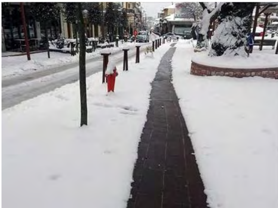
Σχήμα 3. Θερμαινόμενο πεζοδρόμιο στο Καρπενήσι
