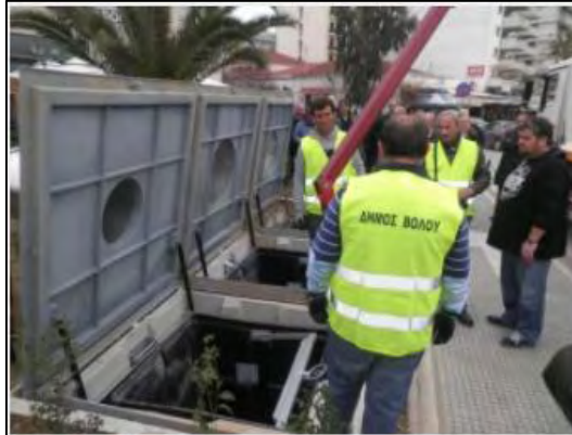
Εικόνα 41: Εγκατάσταση υπόγειων κάδων στην πόλη του Βόλου.
