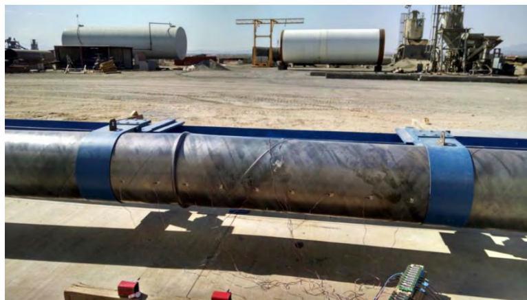
Εικόνα 3. 15: Μορφή αστοχία τέταρτου δοκιμίου ( D/t=191 , χωρίς συγκολλητή σύνδεση).
