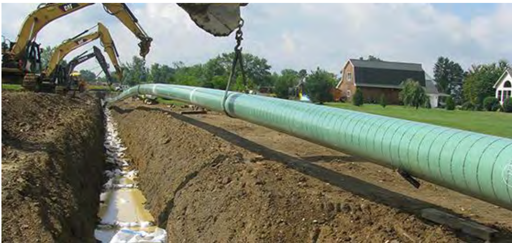
Εικόνα 1. 1: Εγκατάσταση χερσαίου αγωγού.
