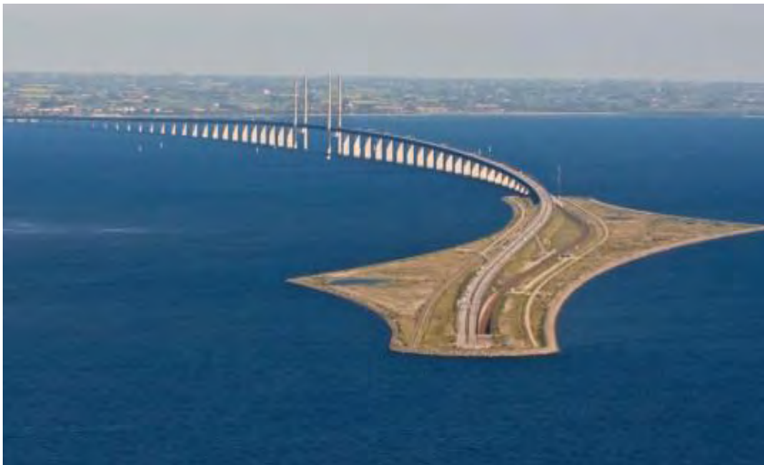
Εικόνα 7: Γέφυρα Øresund, Σουηδία-Δανία
