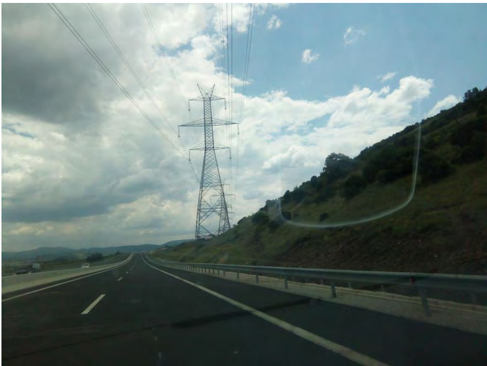
Εικόνα 19: Διασταύρωση με δίκτυο υψηλής τάσης
