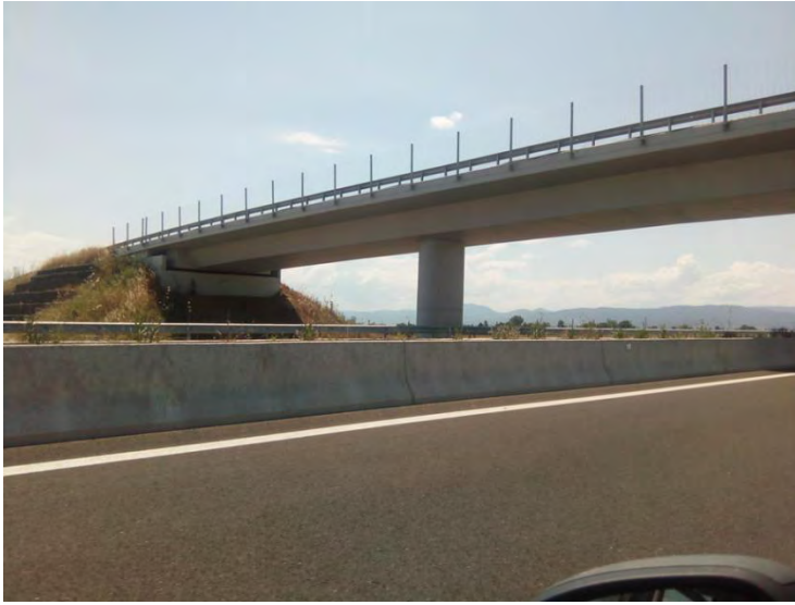
Εικόνα 12: Γέφυρα σύνδεσης επαρχιακών οδών στη ΔΕ Σοφάδων
