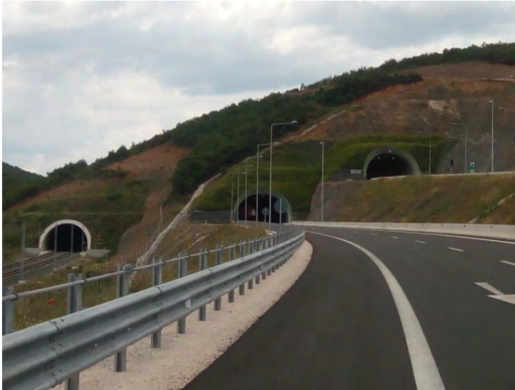
Εικόνα 16: Σήραγγες E-65 πριν τον Άγιο Στέφανο και σιδηροδρομική σήραγγα
