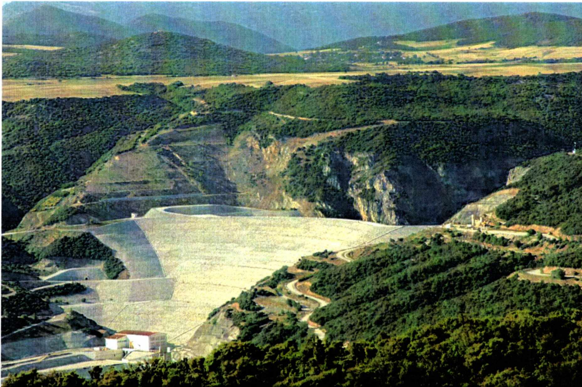
Εικόνα 3.5 Φωτογραφία δεξιού αντερείσματος
