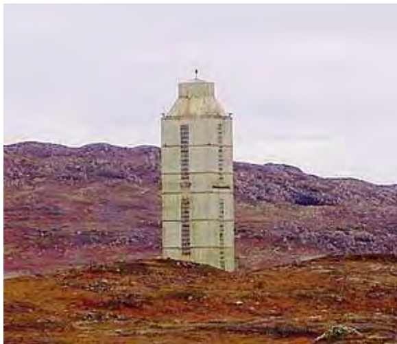
Σχήμα I.1 Ανωδομή της γεώτρησης στην χερσόνησο Κόλα, το 2007 (Kola Superdeep Borehole) [6].
