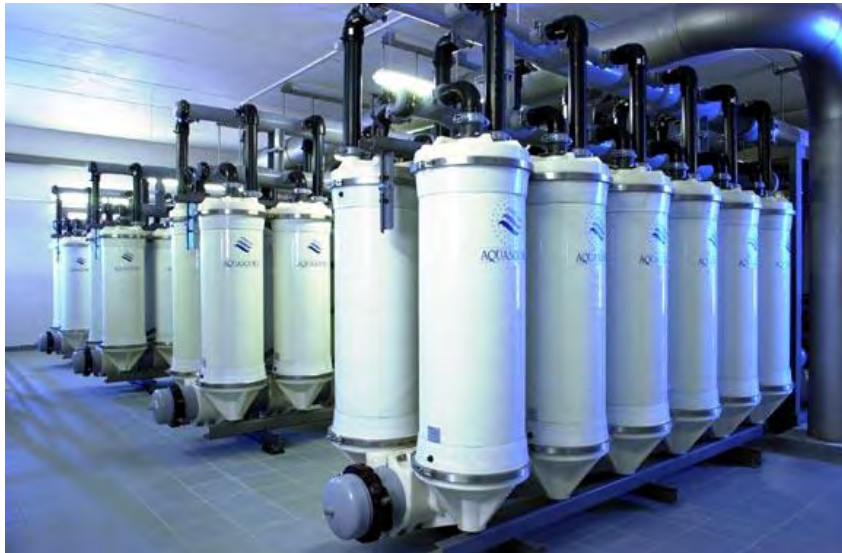
Εικόνα 4.1: Απεικόνιση διάταξης μεμβρανών αντίστροφης ώσμωσης επεξεργασίας θαλασσινού νερού SWRO[12]
