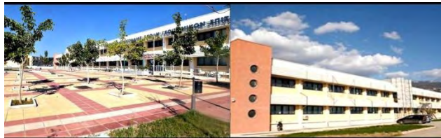
Εικόνες 4.11, 4.12: Το νέο κτίριο της Γεωπονικής Σχολής
