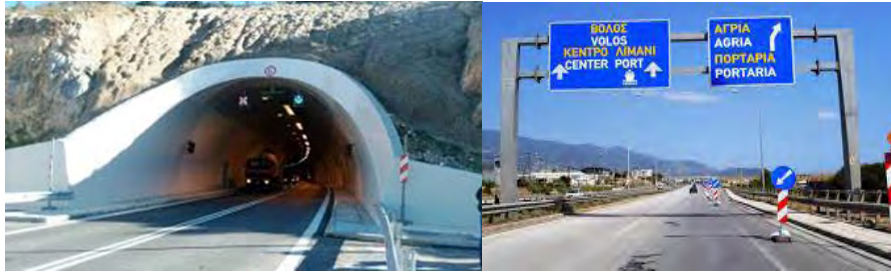
Εικόνες 3.5, 3.6: Σήραγγα Γορίτσας, Περιφερειακός Δρόμος Βόλου
