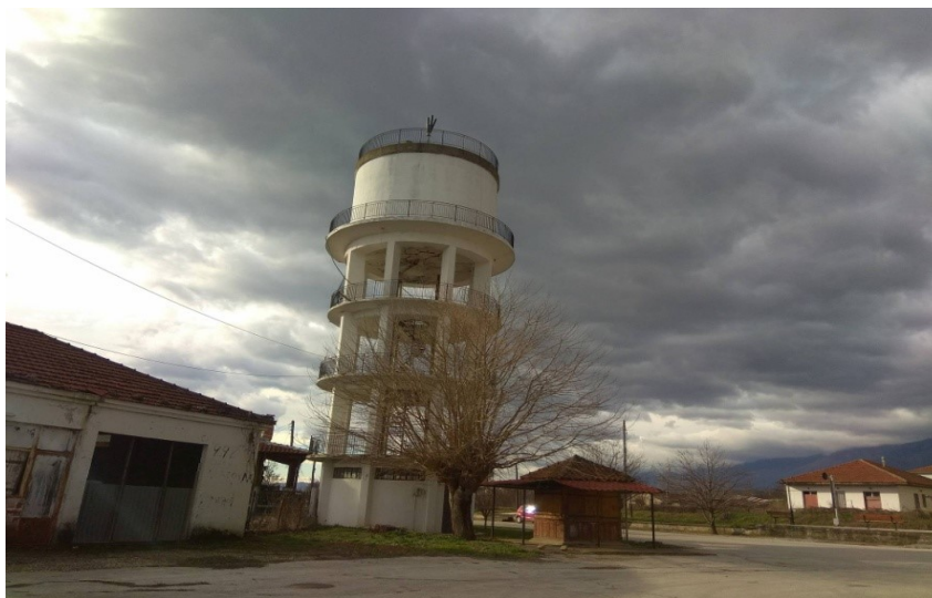
Εικόνα 2.2 : Δεξαμενή νερού σε αυξημένη υψομετρική θέση (Λιθότοπος, Σερρών)
