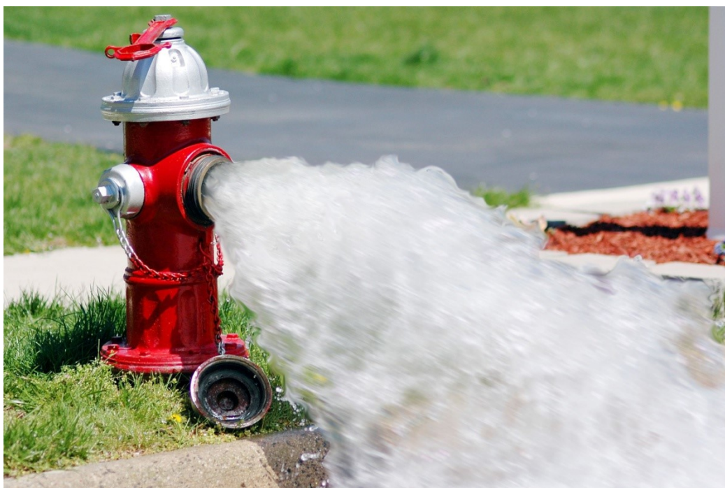
Εικόνα 2.1: Διαδικασία έκπλυσης μέσω πυροσβεστικού κρουνού
