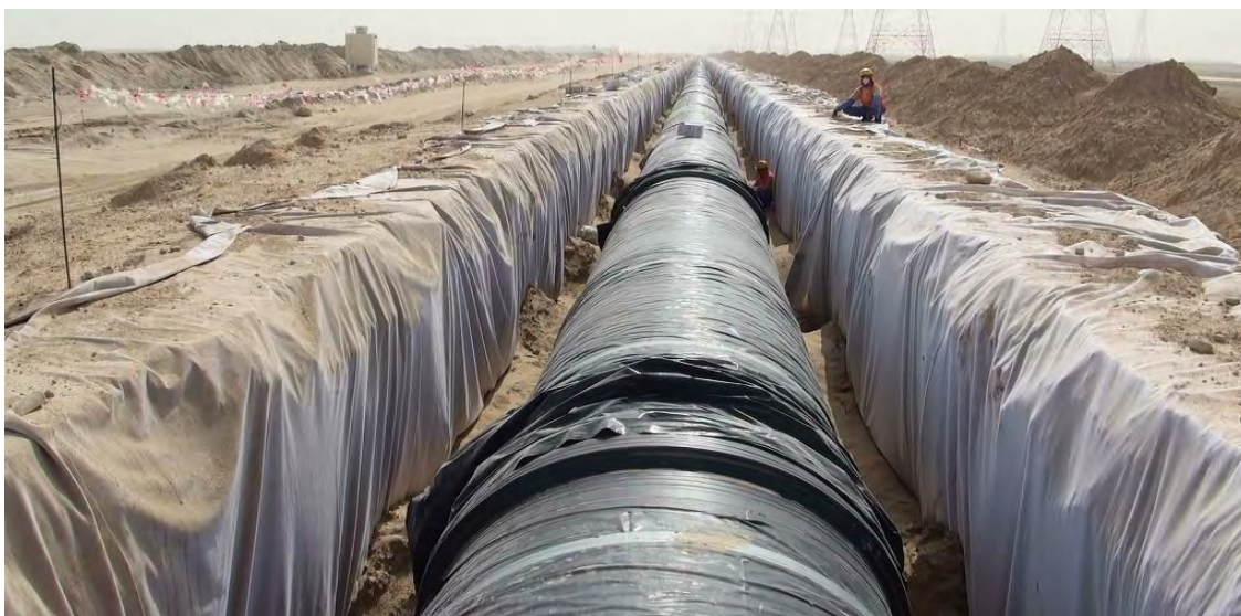
Εικόνα 1: Διαδικασία ελέγχου της κατασκευής ενός αγωγού όλκιμου σιδήρου μήκους περίπου 40 km και διάμετρο 1600 mm, που διανέμει νερό, στην πόλη Musaffah του Αμπού Ντάμπι
