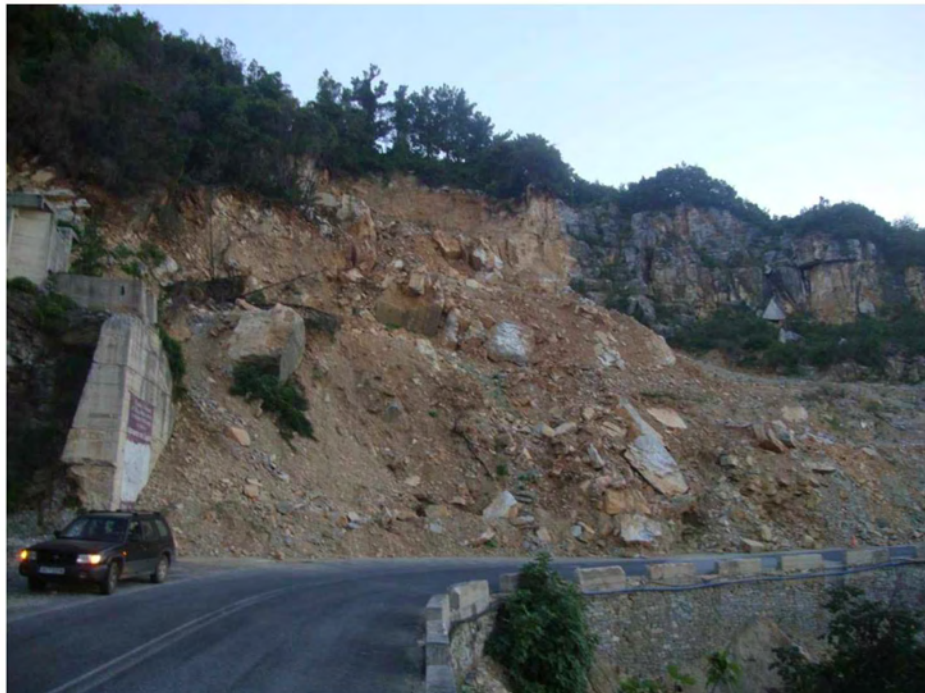
Εικόνα 5.4: Κατολίσθηση στο 48 ο χιλιόμετρο Βόλου – Νεοχωρίου – Ζαγοράς [31]
