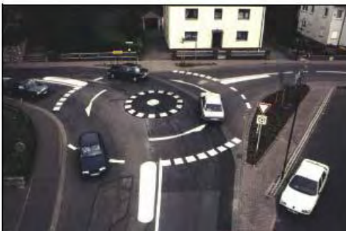
Εικόνα 2.15 Κομβίδια με υπερυψωμένη, πλήρως διελεύσιμη κεντρική νησίδα(ΟΜΟΕ Κ 3 , 2011)
