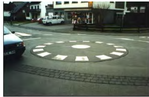
Εικόνα 2.14 Βασικά χαρακτηριστικά κομβιδίου (ΟΜΟΕ Κ 3 , 2011)
