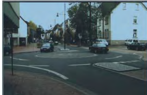
Εικόνα 2.15 Κομβίδια με υπερυψωμένη, πλήρως διελεύσιμη κεντρική νησίδα(ΟΜΟΕ Κ 3 , 2011)
