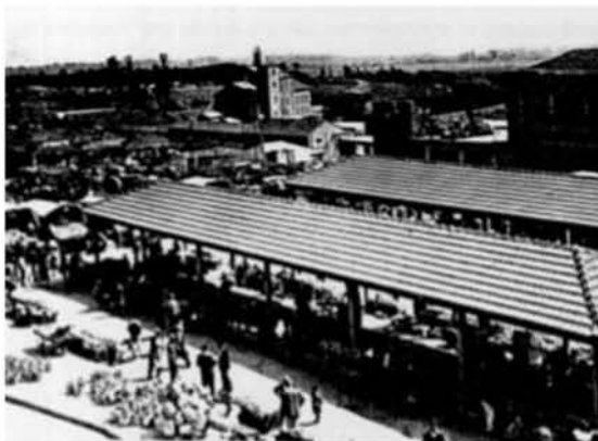
Εικόνα 8: Τα στέγαστρα της λαχαναγοράς πριν την κατεδάφισή τους
