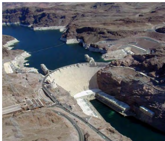
Εικόνα 1.2 Φράγμα Βαρύτητας, Hoover, Αριζόνα [2].
