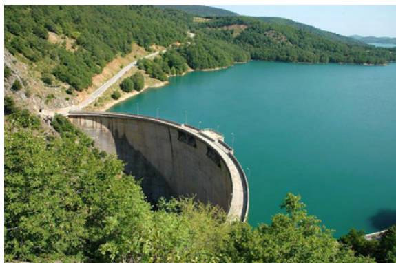
Εικόνα 1.3 Τοξωτό Φράγμα Πλαστήρα (Ταυρωπού) [3].
