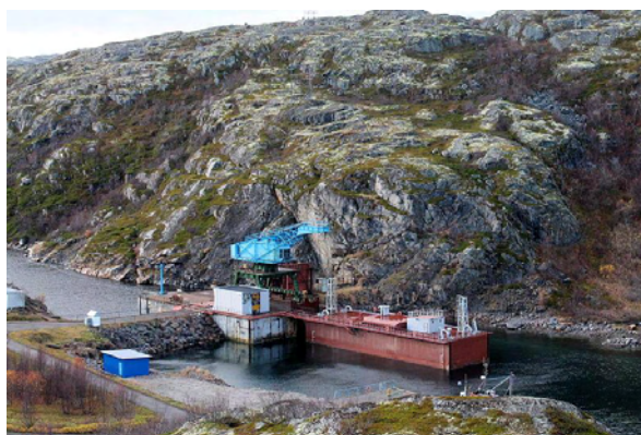
Εικόνα 4.17: Ο παλιρροϊκός υδροηλεκτρικός σταθμός στην περιοχή της Gislaya Guba στη Ρωσία. Πηγή: https://en.wikipedia.org/wiki/Kislaya_Guba_Tidal_Power_Station#/media/File:Kislaya_Guba_tidal_power_station.JPG
