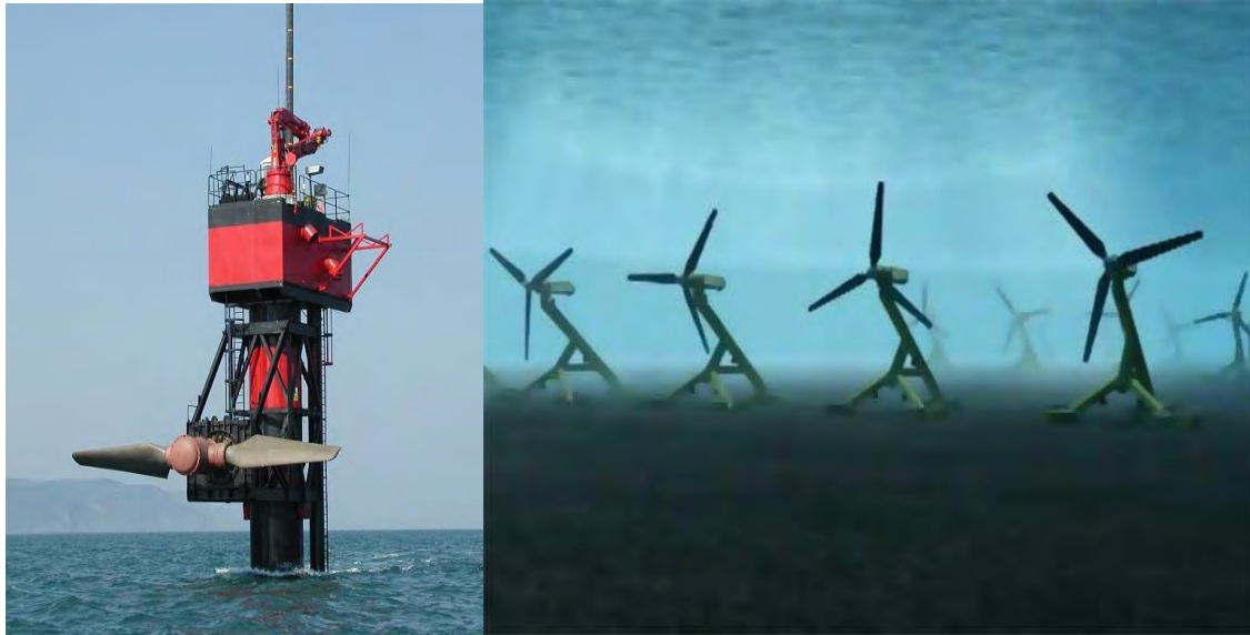
Εικόνες 2.3 και 2.4: Η παλιρροϊκή γεννήτρια SeaFlow της εταιρίας MCT Ltd (αριστερά) και προσομοίωση συστοιχιών υδροστροβίλων ή «παλιρροϊκής φάρμας» (δεξιά).
