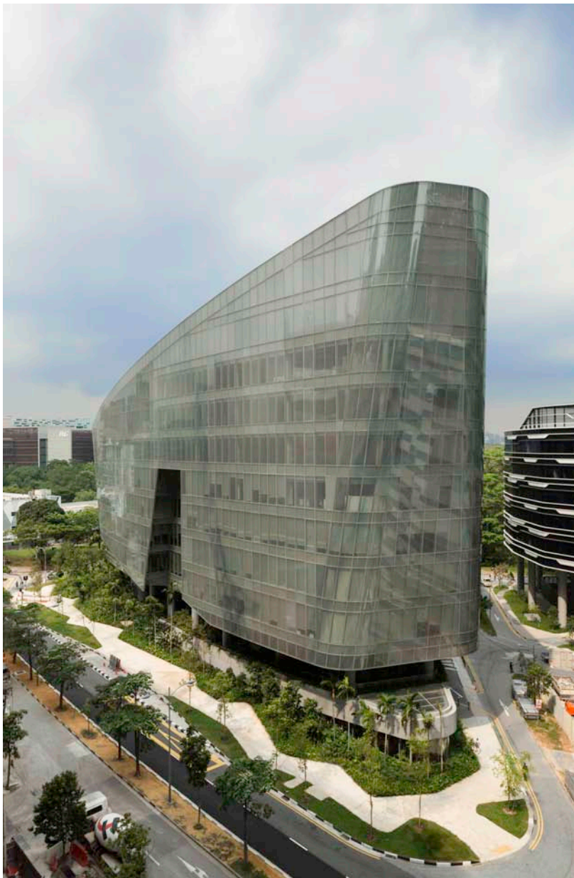
Εικόνα 07. Το κτίριο Sandcrawler, που φιλοξενεί μια συναυλιακή αίθουσα αλλά και εμπορικές χρήσεις (Πηγή: https://www.aedas.com/en/what-we-do/featured-projects/the-sandcrawler )
