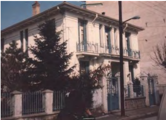
Εικόνα 26: Διατηρητέο κτίριο της οδού Πρεσπών 14
