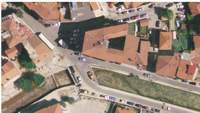
Εικόνα 41: Έλλειψη πεζοδρομίων στην περιοχή του ποταμού Σακουλέβα πριν την ανάπλαση
