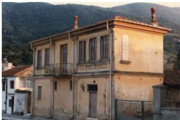
Εικόνα 25: Διατηρητέο κτίριο της οδού Πλατείας Ηρώων 3
