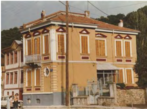
Εικόνα 19: Διατηρητέο κτίριο οδού Λ. Ελευθερίας 83
