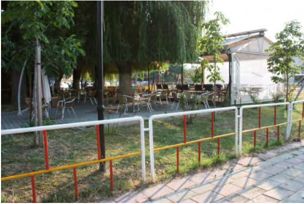
Εικόνα 34: Χώρος τραπεζοκαθισμάτων αναψυκτηρίου πριν την ανάπλαση
