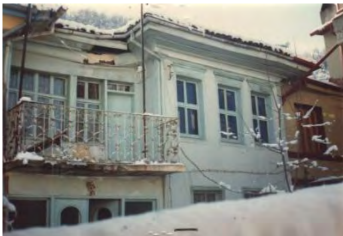
Εικόνα 20: Διατηρητέο κτίριο οδού Λ. Ελευθερίας 87
