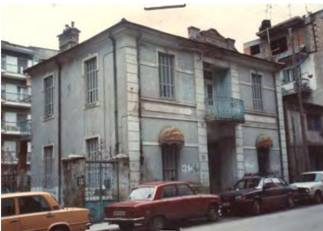
Εικόνα 27: Διατηρητέο κτίριο της οδού Σαρανταπόρου 26
