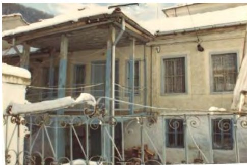
Εικόνα 18: Διατηρητέο κτίριο οδού Λ. Ελευθερίας 51
