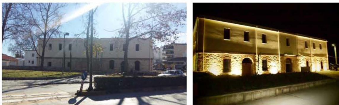
Εικόνα 14: Το παλιό κτίριο των φυλακών (σημερινό Μουσείο «Τσιτσάνη»). Πηγή: Διαδίκτυο.
