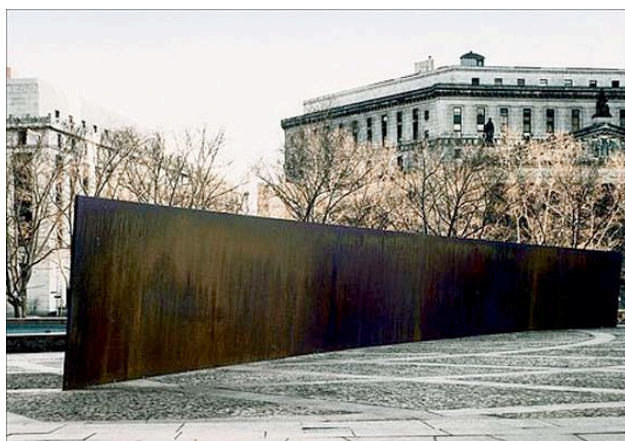
Τοποθεσία: Jacob Javits Ομοσπονδιακό Κτίριο, Νέα Υόρκη, 1981-1989.
