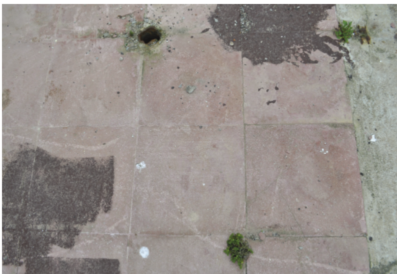
Βάθρο στήριξης υποστυλώματος των μεταλλικών στεγάστρων πηγή: προσωπικό αρχείο
