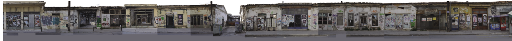
Όψη αποτύπωσης οδός Αρεθούσης
