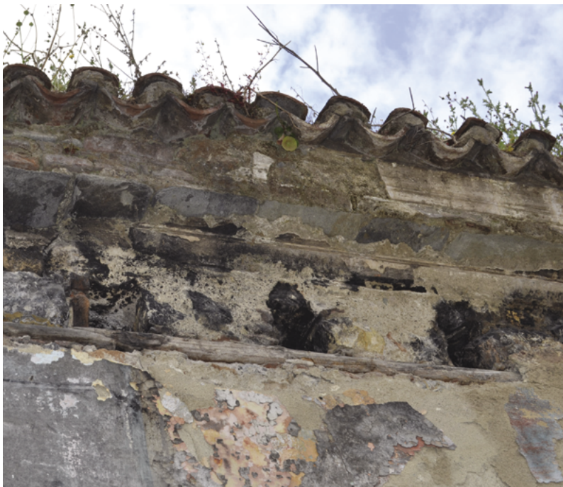
Λεπτομέρεια οπών στη λιθοδομή των περιμετρικών κτιρίων πηγή: προσωπικό αρχείο
