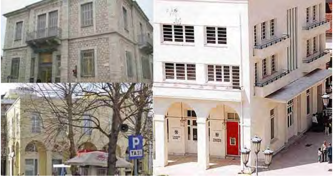
Εικόνες 82 - 84. Κτίρια υποκαταστημάτων τραπεζών: Εθνικής Τράπεζας «πέτρινο», πρώην Εμπορικής Τράπεζας, AlphaBank – Παλλάς (πηγή: Δήμος Καρδίτσας)
