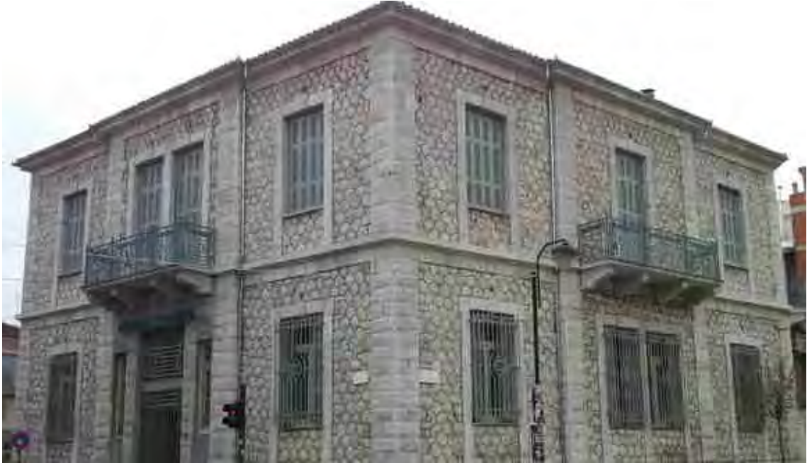
Εικόνα 48. Το πέτρινο κτίριο της Εθνικής Τράπεζας (Πηγή: http://touristikosodigoskarditsas.weebly.com/ )
