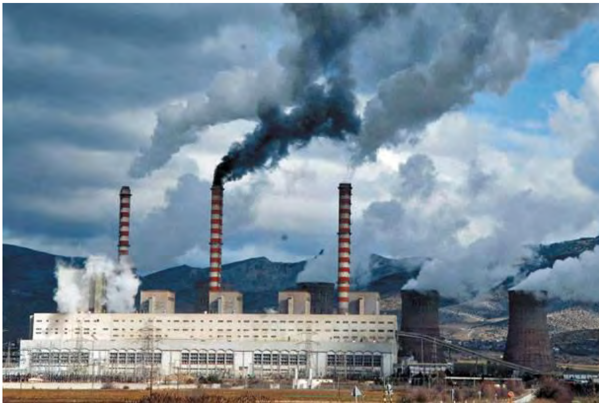
Εικόνα 27: Οι εγκαταστάσεις της Δ.Ε.Η στη περιοχή της Κοζάνης
